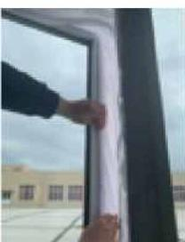
5. Fixez le côté étroit B (fermeture à glissière fermée) du centre vers la gauche et la droite ou de haut en bas sur le battant.
