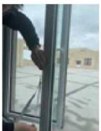
**2.** Befestigen Sie den Klettverschluss innen oder außen am Fensterflügel (Seite A). Die Seite, an der sich der Griff befindet.
