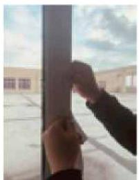
**1.** Öffnen Sie zuerst das Fenster und reinigen Sie alle Oberflächen, an denen der Klettverschluss befestigt werden soll. Reinigen Sie die Oberflächen des Rahmens und des Flügels, damit kein Staub und Fett entsteht. Öffnen Sie das selbstklebende Teil des Klettbandes und befestigen Sie es am Fensterflügel.
