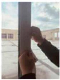
1. Ouvrez d'abord la fenêtre et nettoyez toutes les surfaces sur lesquelles la bande Velcro doit être fixée. Nettoyez les surfaces du cadre et du vantail afin qu'il n'y ait ni poussière ni graisse. Ouvrez la partie auto-adhesive de la bande Velcro, fixez-la au battant de la fenêtre.
