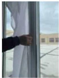
3. Fixez d'abord la partie large (côté A) du tissu d'étanchéité (fermeture à glissière fermée) avec la fenêtre ouverte. Commencez au milieu, puis fixez à gauche et à droite ou de haut en bas sur le cadre de la fenêtre.
