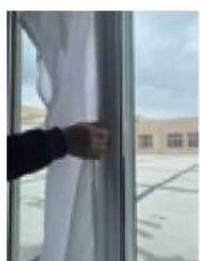
**3.** Befestigen Sie zuerst den breiten Teil (Seite A) des Versiegelungstuchs (Reißverschluss geschlossen) bei geöffnetem Fenster. Beginnen Sie in der Mitte und befestigen Sie dann links und rechts oder oben und unten am Fensterrahmen.
