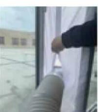
**6.** Öffnen Sie das Fenster leicht und ziehen Sie den Entlüftungsschlauch mit dem Reißverschluss durch das Fensterdichtungsset heraus.
