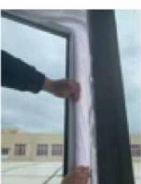
**5.** Befestigen Sie die schmale Seite B (Reißverschluss geschlossen) von der Mitte nach links und rechts oder auf und ab am Flügel.
